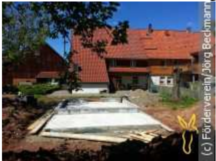
Bodenplatte und Sockel
