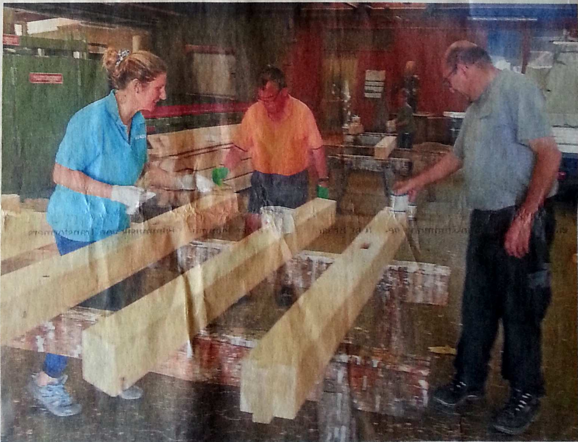
Die Balken werden im Zimmereibetrieb geölt.
